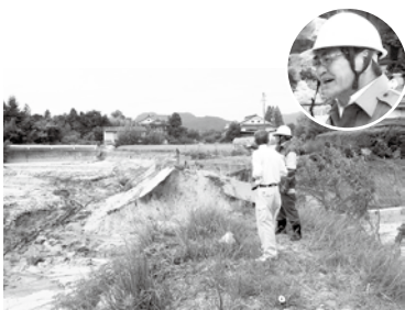
広島ため池災害調査の様子
