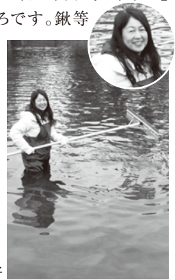
清掃作業の様子
